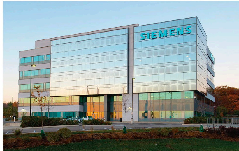
Office (Siemens, Oakville)
